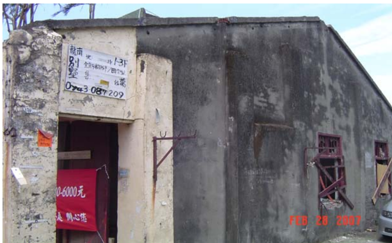
圖六：中壢龍岡忠貞新村眷村，一一拆除的現貌，目前興建大樓。(游惠晴攝)
